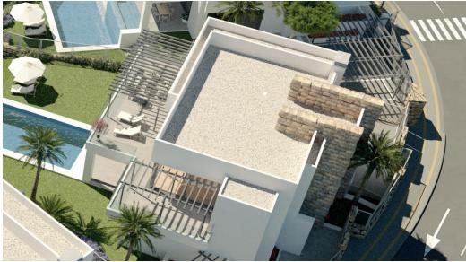
La cubierta con uso exclusivo para instalaciones, se ejecuta mediante sistema de Cubierta Plana no transitable, impermeabilizada y aislada térmicamente, con acabado en grava.
